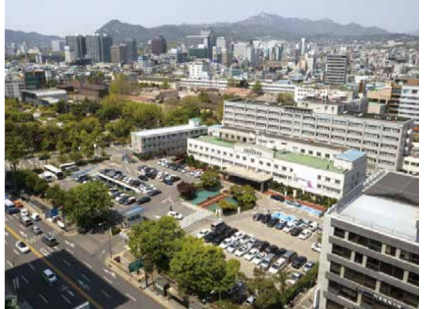
을지로에 있는 국립중앙의료원 전경. 건너편에 환경원공영권과 미군 극동공병단 부지가 보인다.
